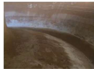
Fond de cuve
