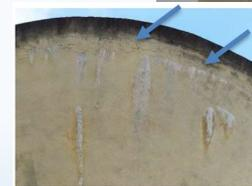
Voile cuve – fissures avec épanchement de calcite à la jonction entre le voile de cuve et l'acrotère
